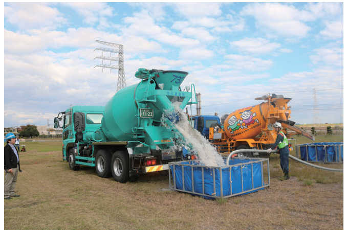
ミキサー車による消火用水の供給
